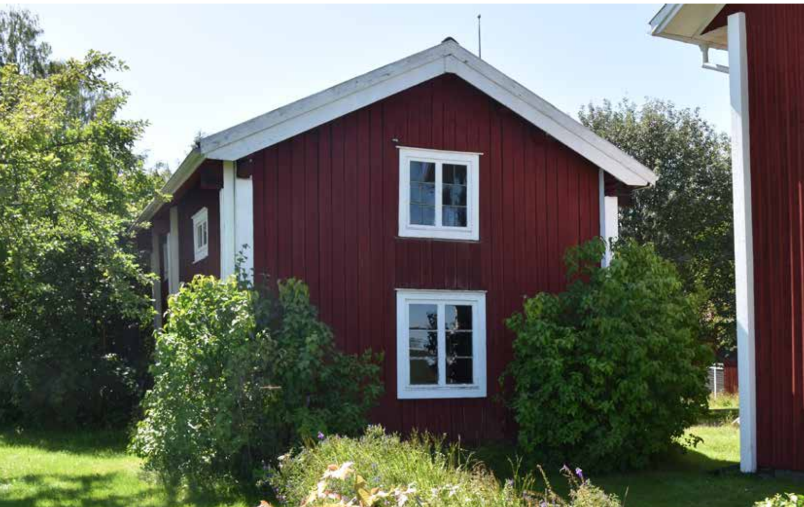
Ålderdomligt timmerhus med blyspröjsade fönster. Det övre fönsterparet kan vara från 1700-talet. Yttermo 40:3.
