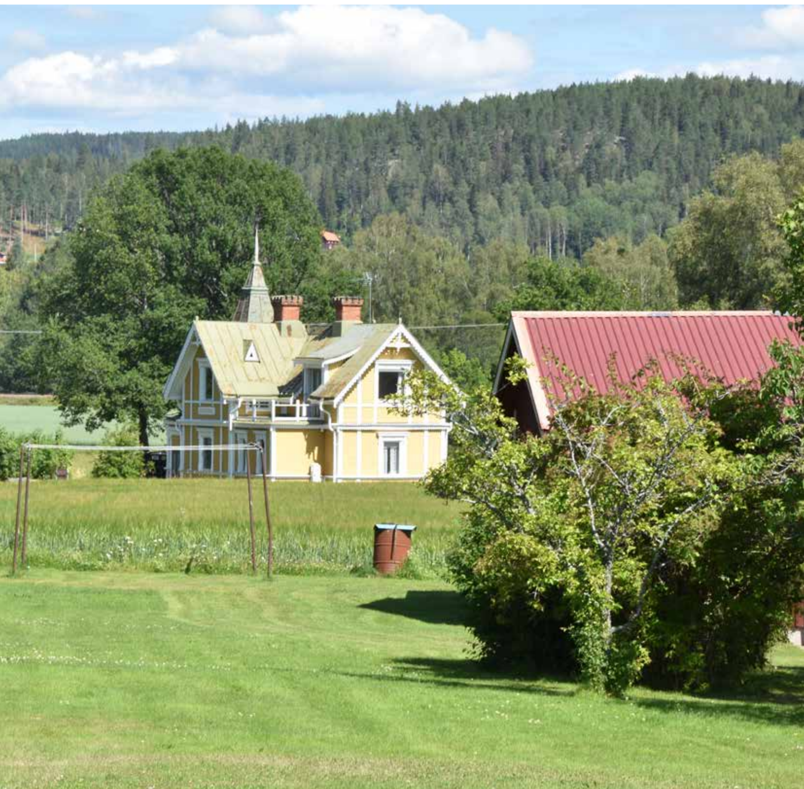
Sekelskiftesvillan Eriksdal med krenelerade skorstenar, skivplåttak i koppar och många detaljer i snickarglädjestil. Yttermo 16:13.
