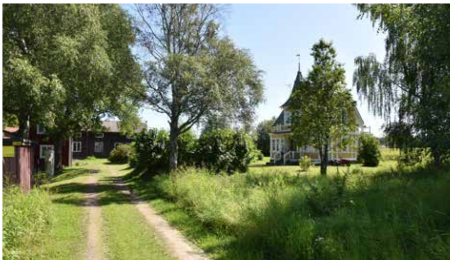
Sekelskiftesvillan Eriksdal i nordöstra delen av byn. Byggnaden har ett karaktäristiskt torn och många detaljer i snickarglädjestil. Yttermo 35:3.
