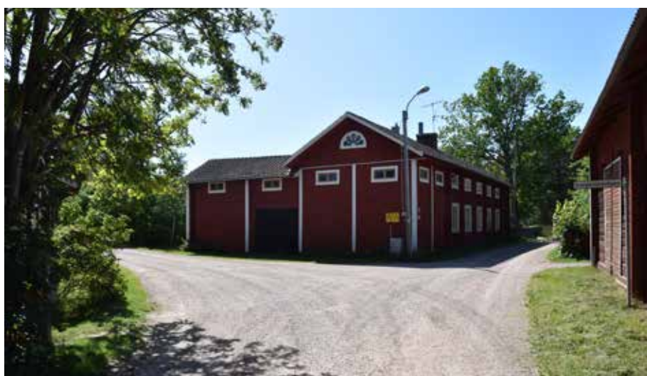
Stor ekonomibyggning med bostadsutrymmen sannolikt tillkommen i sin nuvarande utformning under 1800-talets senare hälft. Det dekorativa gavelfönstret är mycket karaktäristiskt. Yttermo 43:6.
