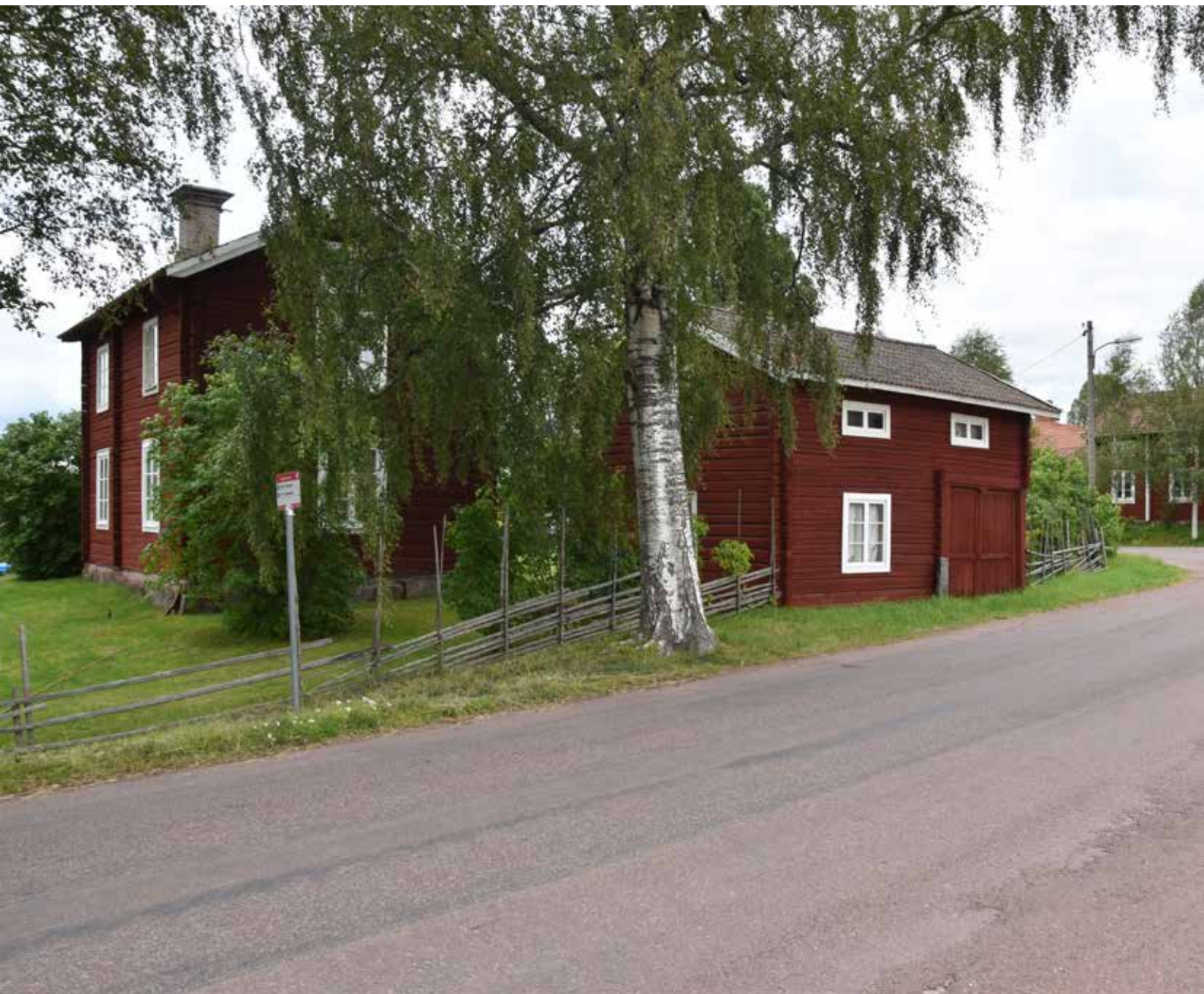
Gård med ålderdomlig enkelstuga och vinkelställd portlidersbyggnad med bostadsutrymmen. Gården har utglesats från andra ekonomibyggnader. Västannor 33:3.
