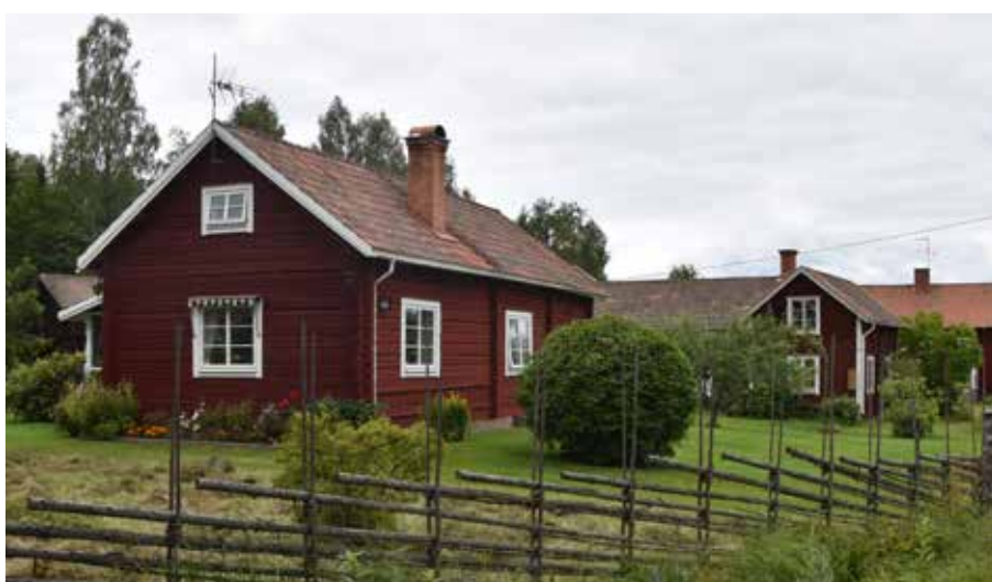
Timmerhus uppfört under den moderna epoken i den södra delen av byn. Västannor 25:3.
