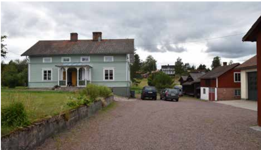
Dubbelkorsplanshus med lig-gande och stående panel sannolikt uppförd under slutet av 1800-talet. Byggnadens fönster och detaljutformning är tidstypisk för det sena 1800-talets snickarglädjestil. Västannor 22:11.
