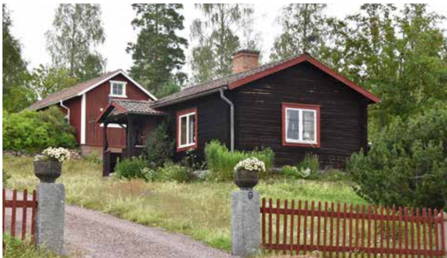
Sommarnöje med högkvalitativ detaljutformning. Byggnaden har exempelvis blyspröjsade fönster och en enkelt utformad farstukvist. Ullvi 48:8.
