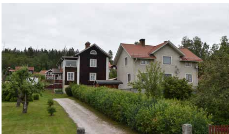
Gård med moderniserad äldre salsbyggnad som även är reveterad (putsad) invid ett äldre bostadshus med synligt timmer. Ullvi 10:16 och Ullvi 27:2.
