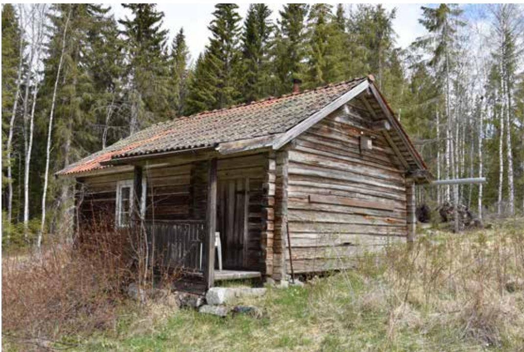
Enkelstuga med farstuvist och rörskorsten. Västra Rönäs 15:5.
