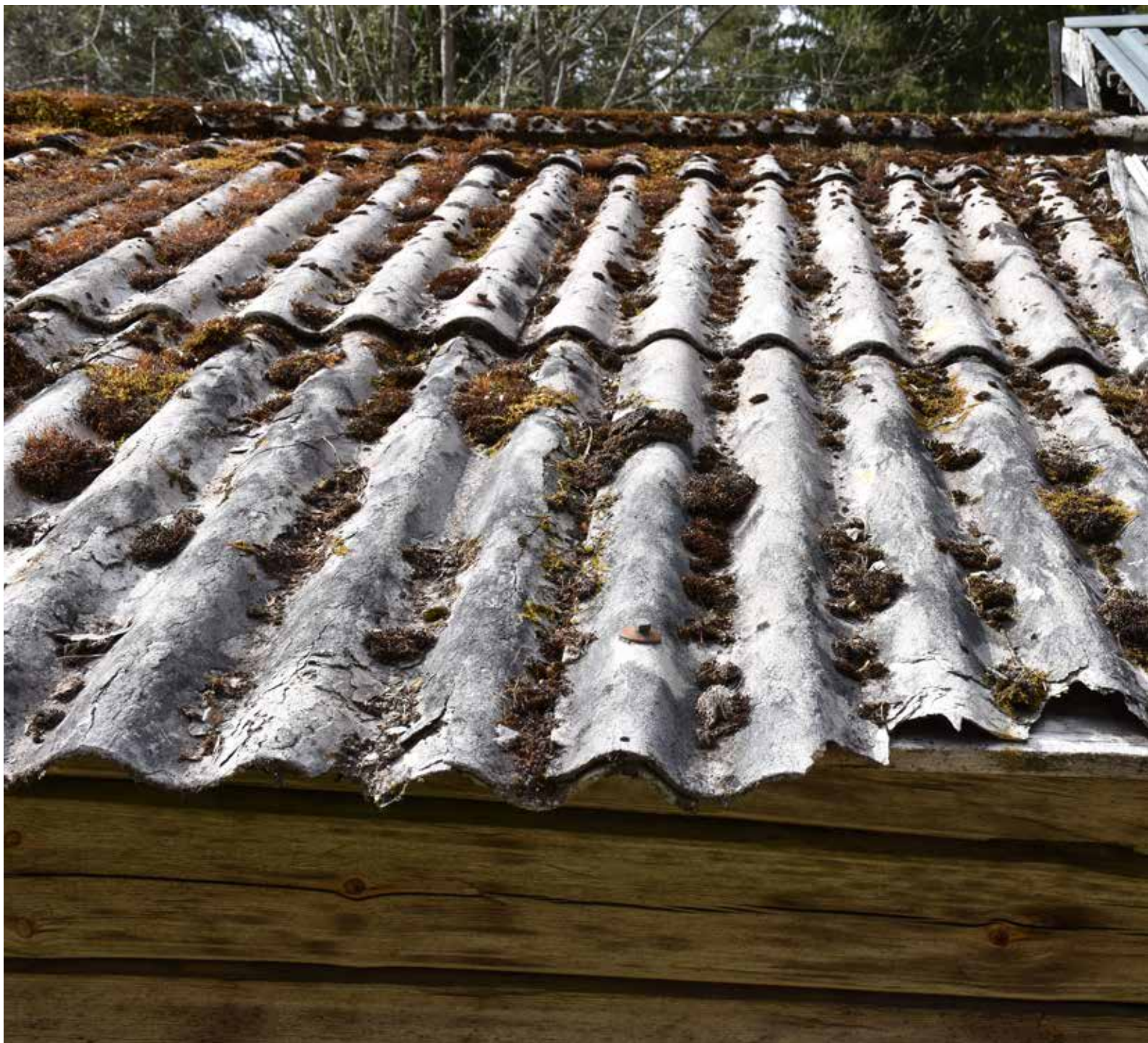
Takskivor i eternit på en av fäbodstugornas ekonomibygnader. Tibble 8:13.
