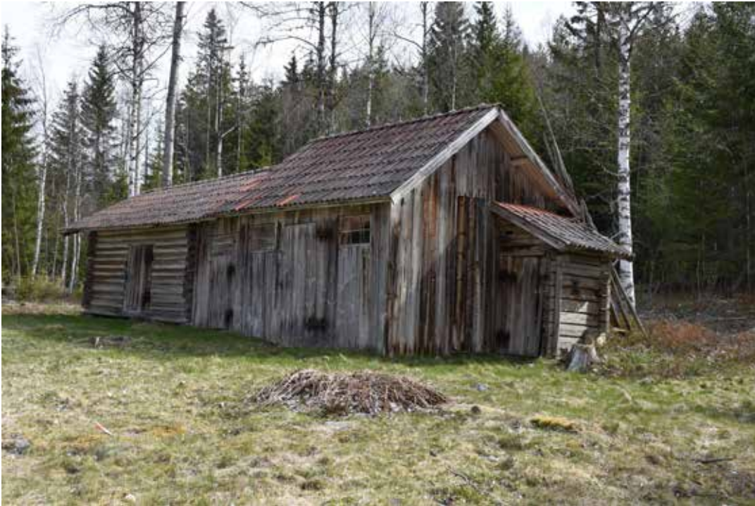
Byggnadskropparna är i regel långa och smala och aldrig högre än en våning. Laknäs 20:2I.
