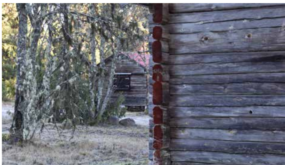
Spår av faluröda knutändar på en av fäbodstugorna. Faluröda knutändar har i vissa fall förekommit på fäbodarna historiskt. Vid ommålning bör endast knutändarna färgas röda, som bilden visar.
