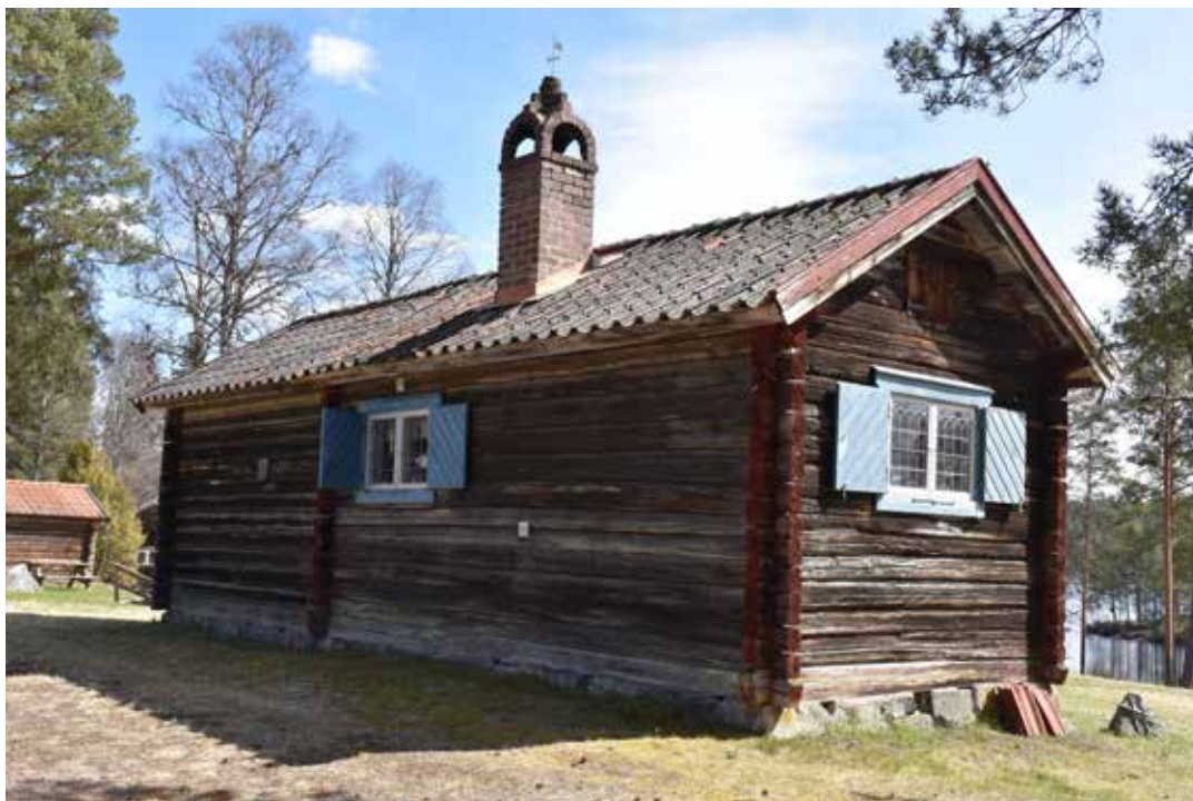
Flera av stugorna vid Gäddtjärn har under 1900-talet moderniserats med spröjsade blyfönster samt fönsterluckor och foder i dalablått. Lägga märke till den fint murade kronskorstenen. Tällberg 23:10.
