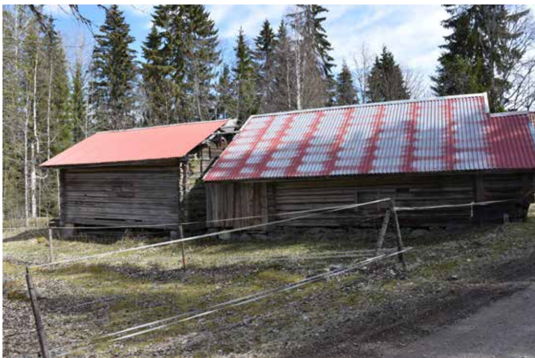
Även om tvåkupigt lertegel är vanligt förekommande finns även ett stort antal byggnader på fäbodsområdet som försetts med korrugerade plåttak. Lahnäs 39:9.
