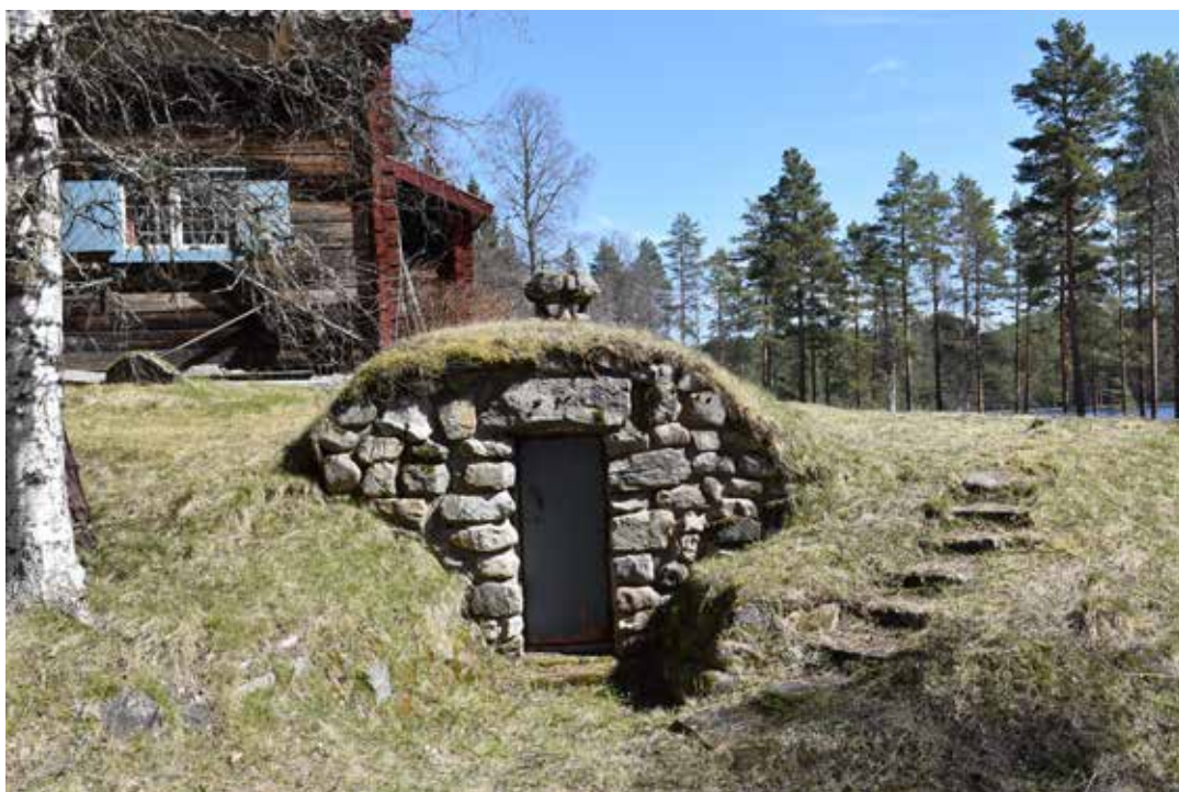
En av fåbodemiljöns enda stensatta byggnader, en jordkällare som troligtvis tillkommit under 1900-talet. Tällberg 23:10.
