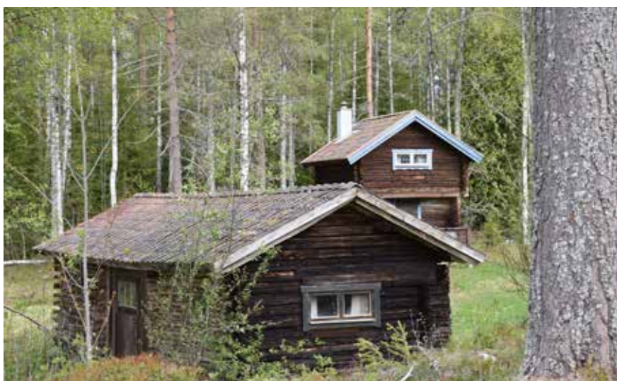
I bakgrunden syns ett äldre härbre som byggts om till sommarnöje. Byggnaden har försetts med blyspröjsade gavelfönster, skorsten och snickerier i dalablått. Ål-Kilen 19:8.
